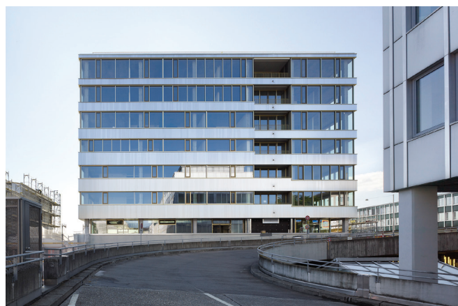
Bild 4 Die neue Fassade orientiert sich an der neuen Nutzung mit großen Panoramafensterbändern, nimmt aber in der Materialisierung Elemente der alten Fassade auf
